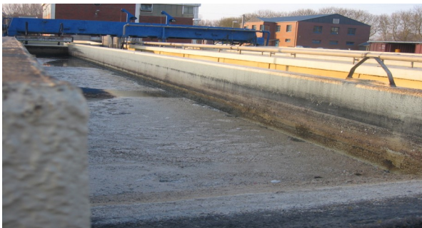
Abbildung oben: Sand- und Fettfang der Zentralen Kläranlage mit oben auf schwimmender Fettschicht
