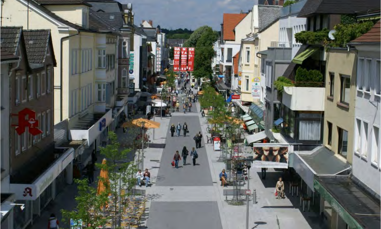
Abb. 145: Klare Straßenraumgliederung und einheitliches Auftreten führt zu einer attraktiven Erscheinung; Quelle: Stadt Arnberg
