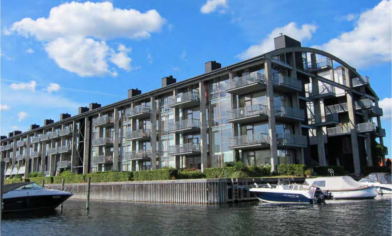
Abb. 140: Bestandsumnutzung zum Wohnen in Wasserlage
