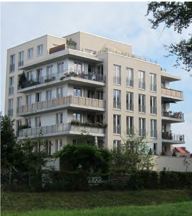
Abb. 152: Moderner barrierefreier Geschosswohnungsbau
